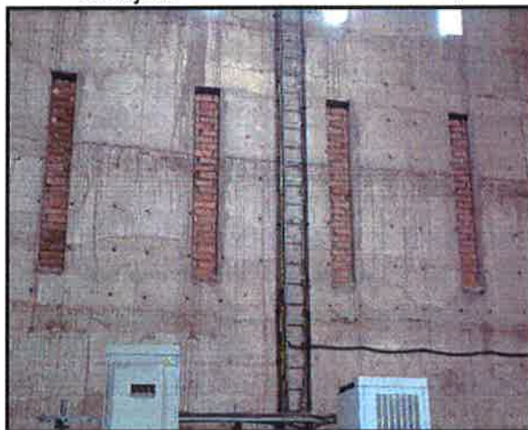
Ilustración 19 Visualización de vanos de ventilación.
