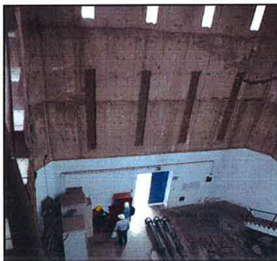
Ilustración 7 Visualización de vanos de ventilación.
